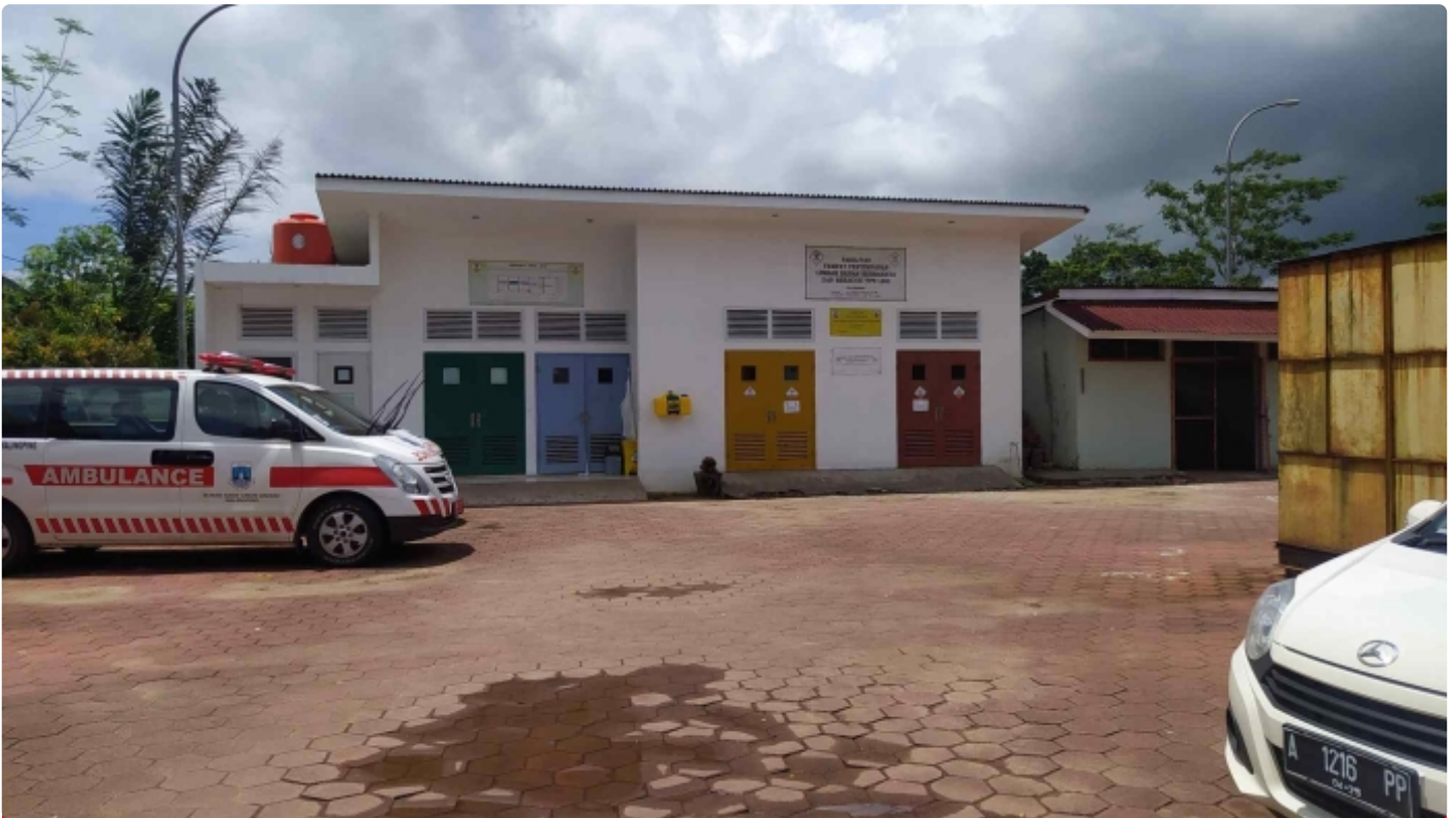
Ruang/gedung instalasi TPSL B3 RSUD Malingping
